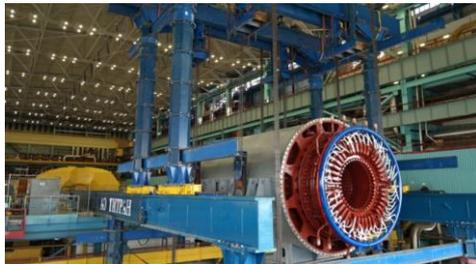
В ходе ремонтной кампании на энергоблоке №3 Калининской АЭС выполнена одна из основных операций – на штатное место установлен новый статор генератора, сообщили 6 июня на атомной станции.
