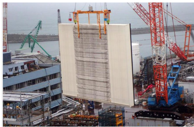
Демонтаж боковой панели защитной конструкции на блоке №1 АЭС «Фукусима-I», фото: TEPCO
