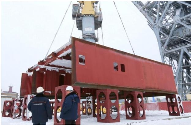
санитарных и бытовых помещений. Надстройка, вес которой составит порядка 2400 тонн, будет установлена на ледокол после его спуска на воду.
