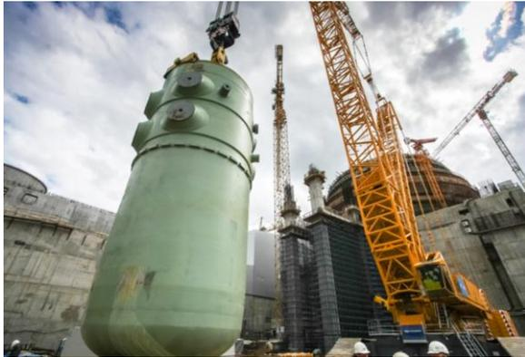
ОАО «МСУ-90» и ОАО «УАТ», сообщили 3 июня в холдинге. Корпус реактора весом 327 тонн был поднят над зданием реактора, проведен между балками полярного крана и установлен на штатное место в проектное положение на опорное кольцо в шахту реактора.
