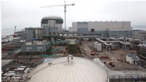
Стройплощадка АЭС «Саньмень» в июле 2014 года, фото: Sanmen Nuclear Power Co., Ltd.
