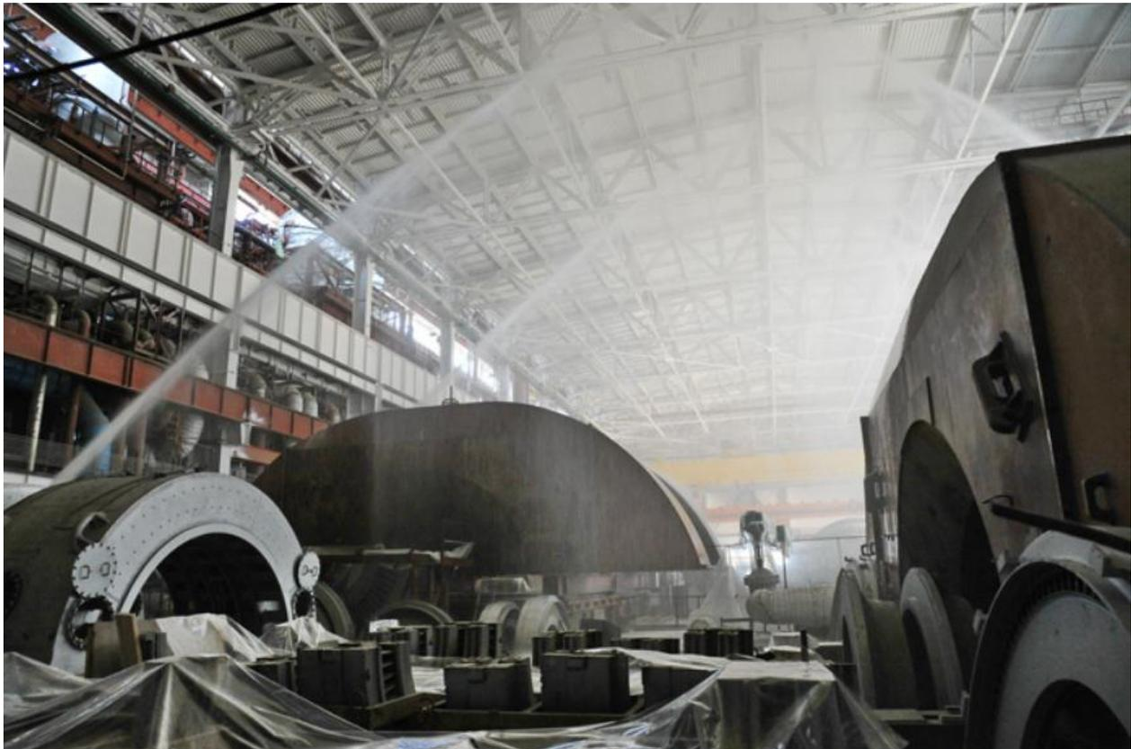
На строящемся энергоблоке №3 Ростовской АЭС проведены испытания оборудования системы пожаротушения – лафетных стволов по орошению ферм кровли машинного зала, сообщили 16 июля на РоАЭС.
