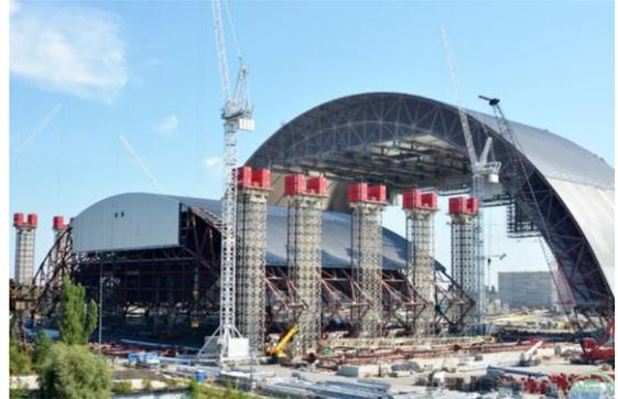
Первый подъем западной части арки НБК (на 22 метра) был выполнен в апреле, а заключительный, третий, подъем планируется в конце текущего года. Восточная часть арки находится в зоне ожидания, выполнен монтаж 12,8 тыс. тонн ее металлоконструкций, продолжают работы по монтажу внешней и внутренней обшивки.
