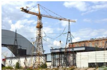
Аварийный проем образовался в результате обрушения кровли и стенных конструкций машзала, которое произошло в феврале 2013 года. Площадь разрушения составила около 600 кв. м. Работы по восстановлению ограждающего контура машзала ведутся с ноября прошлого года.
