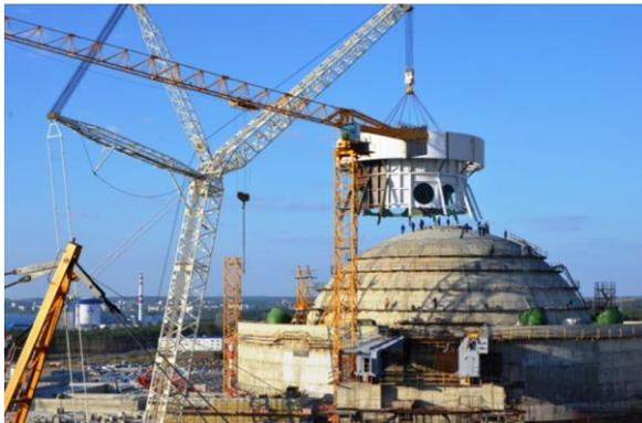
атомной станции. В условиях отсутствия всех источников электроснабжения СПОТ обеспечивает длительный отвод в атмосферу тепла от активной зоны реактора. Принцип работы системы основан на естественной циркуляции: атмосферный воздух (охлаждающая субстанция), попадая в теплообменники, нагревается, по воздуховодам поднимается в выходной коллектор, расположенный наверху купола, откуда возвращается в атмосферу.
