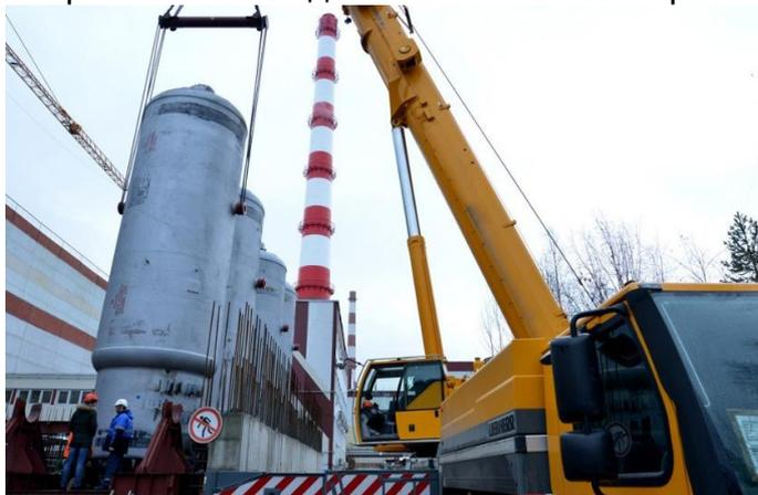
Монтаж основных элементов пассивной системы аварийного охлаждения активной зоны реактора на Кольской АЭС
